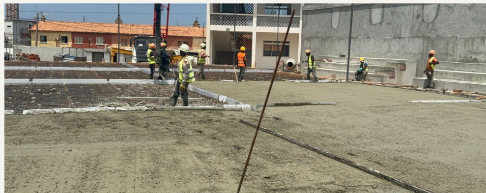
Execução de áreas de circulação.
