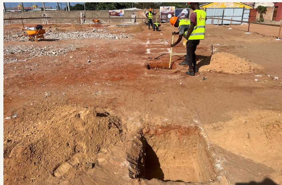
02 / Marcação e escavação das sapatas.
