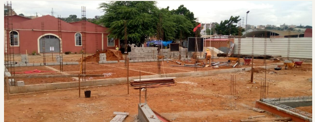
Vigas de fundação.
