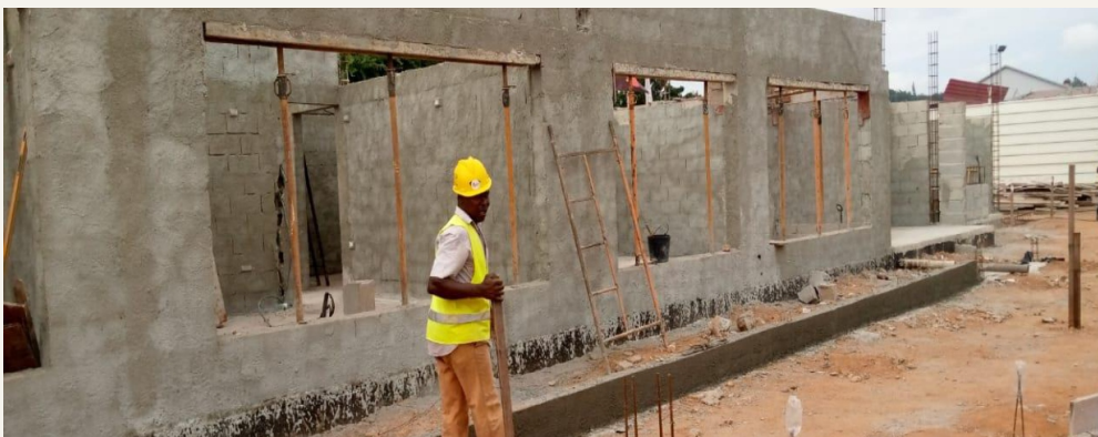
Preparação das paredes para revestimento.
