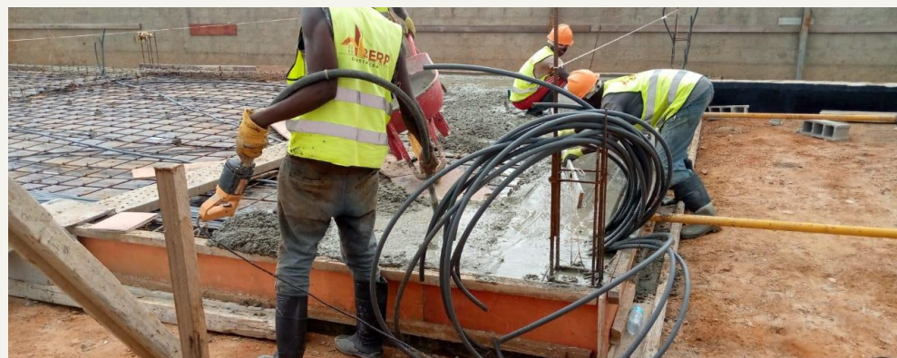
Betonagem da laje.
