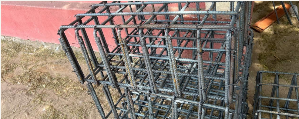
Armaduras das sapatas.
