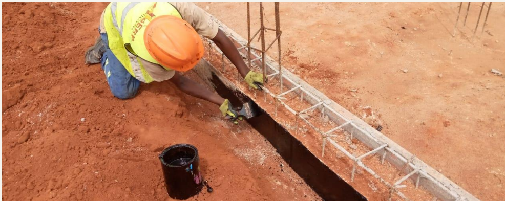
Aplicação de betume asfáltico.
