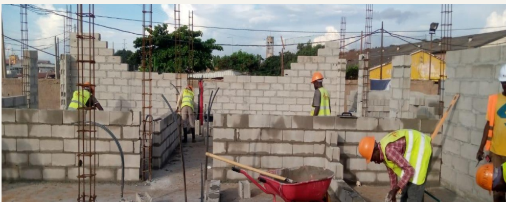
Levantamento das alvenarias.
