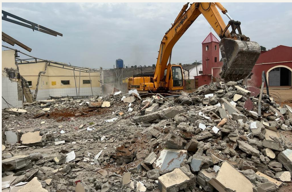
01 / Demolição da antiga escola e remoção dos escombros.
